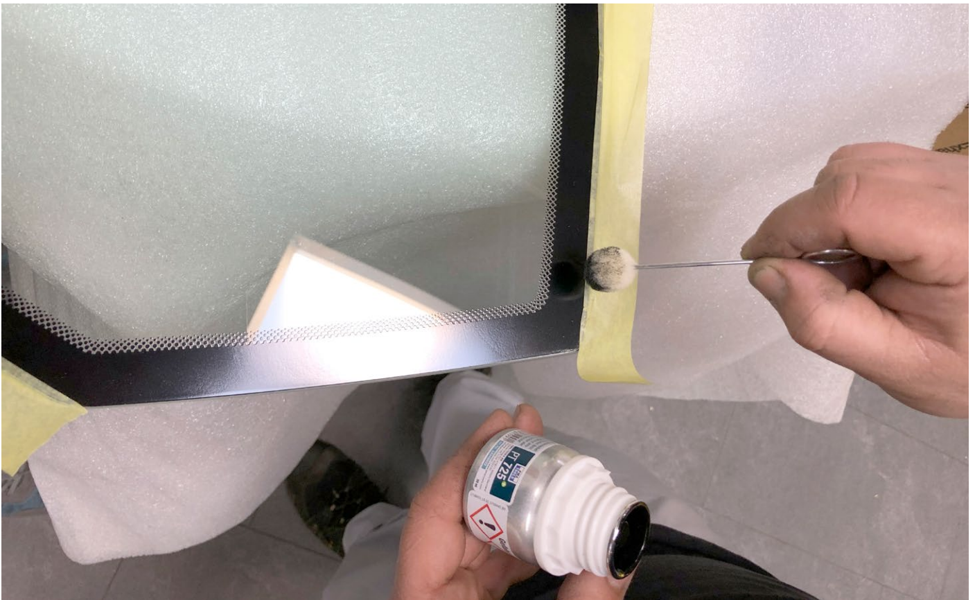
Klebeflächen mit Primer behandeln. Danach das Klebeband abziehen. Treat the surfaces with primer. Remove the tape subsequently.
